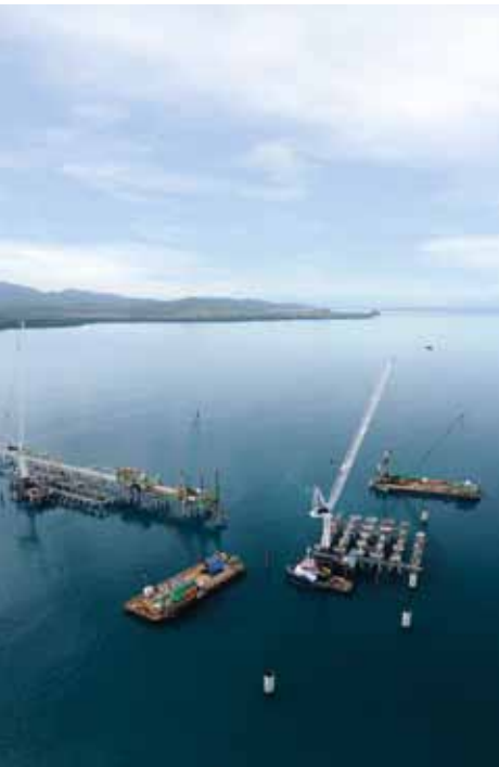
COVER PNG LNG Jetty Project in Papua New Guinea
